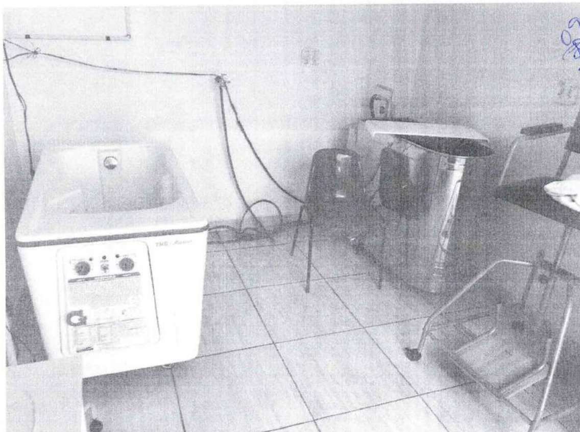
Figura 5 - Equipamento sem higienização adequada, realizada apenas pelas profissionais. Instalações elétricas inadequadas.
