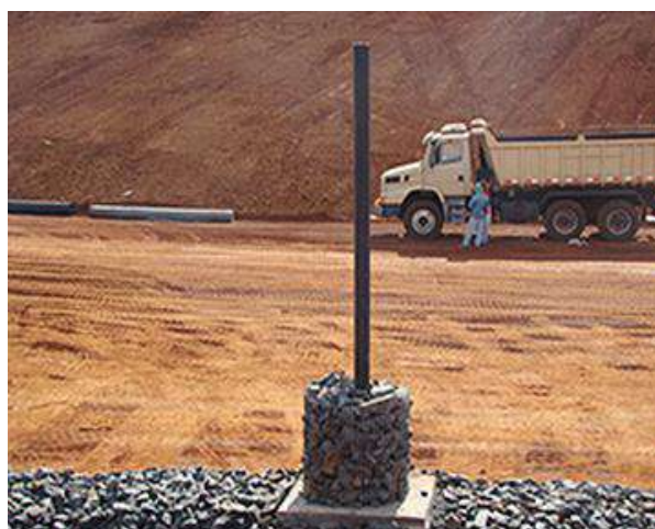
Foto 3.5 – Detalhe de dreno de gases instalados no aterro sanitário particular em Uberaba/MG
