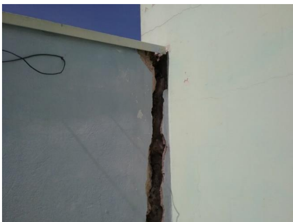
Foto 3 – Trinca em muro de fechamento da unidade de saúde.
