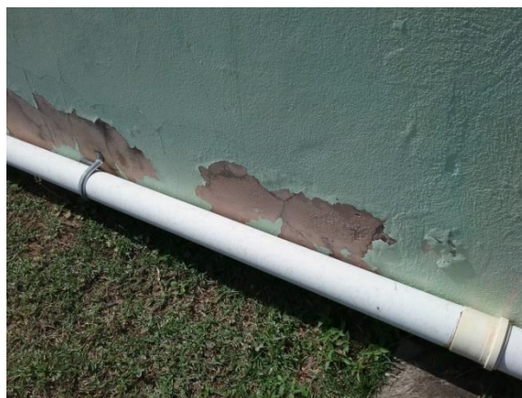
Foto 4 – Pintura descascada.
